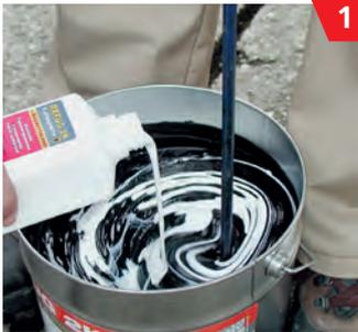
Die Komponente A mit einem Bohrmaschinenquirl gründlich aufrühren und **danach** die Komponente B einrühren.
