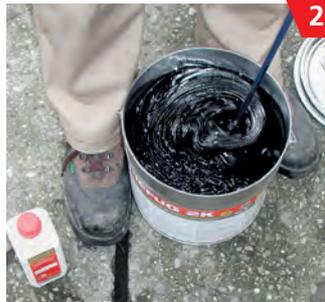
Das Material homogenisieren, bis keine weißen Schlieren mehr sichtbar sind.
