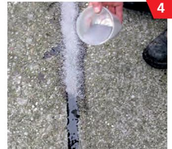
Die gefüllte Fuge kann mit einer Spachtel abgezogen und mit Splitt oder Sand abgestreut werden.
