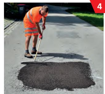
Das eingebaute Mischgut ist abhängig von Witterung und Einbaustärke nach ca. einer halben Stunde befahrbar.
